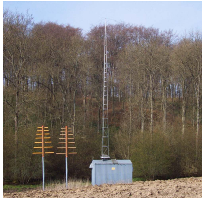
En takmonterad 15 meters antenn
