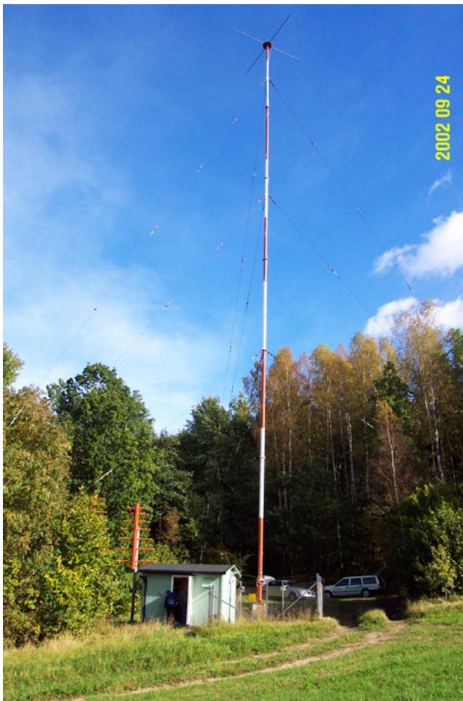
En "Outer Locator" med en 36 m hög antenn med en s k toppkapacitans.
